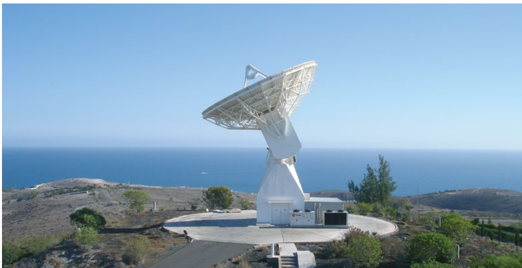
Figura 4: Infraestructuras espaciales. Estación de Maspalomas
